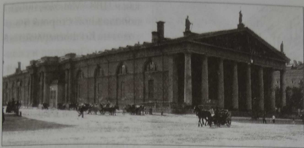
Манеж Конногвардейского полка. Старое фото
